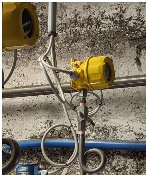
strumentato in conformità alla normativa SIL 61511. Si trattava di impiegare lo strumento con il duplice ruolo di monitoraggio della linea di distribuzione del vapore, comandando allo stesso tempo l'aria compressa pilota di costose valvole di regolazione e blocco, al raggiungimento della soglia critica di sicurezza.
